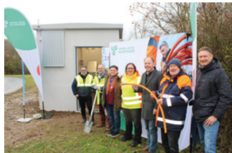
Mitarbeiter der Stadtverwaltung und von „Unsere Grüne Glasfaser“ beim offiziellen Spatenstich zusammen mit Oberbürgermeister Stefan Güntner am Standort des zentralen Hauptverteilungspunktes an der Südtangente.
