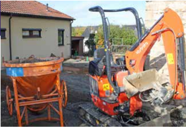
Die Arbeiten am Kindergarten in Hohenfeld schreiten voran.
