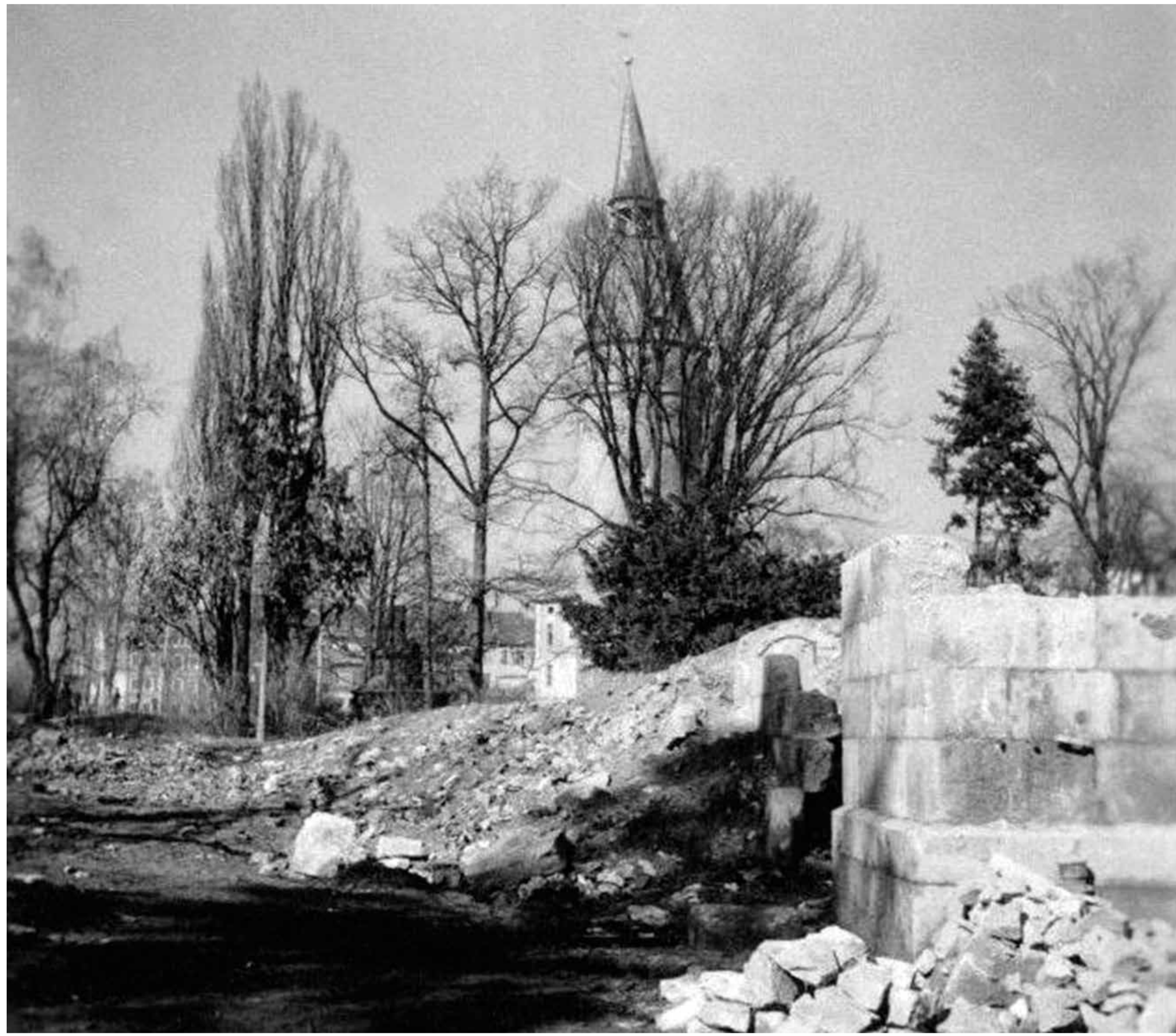
Die schwer getroffene Realschule im Rosengarten
