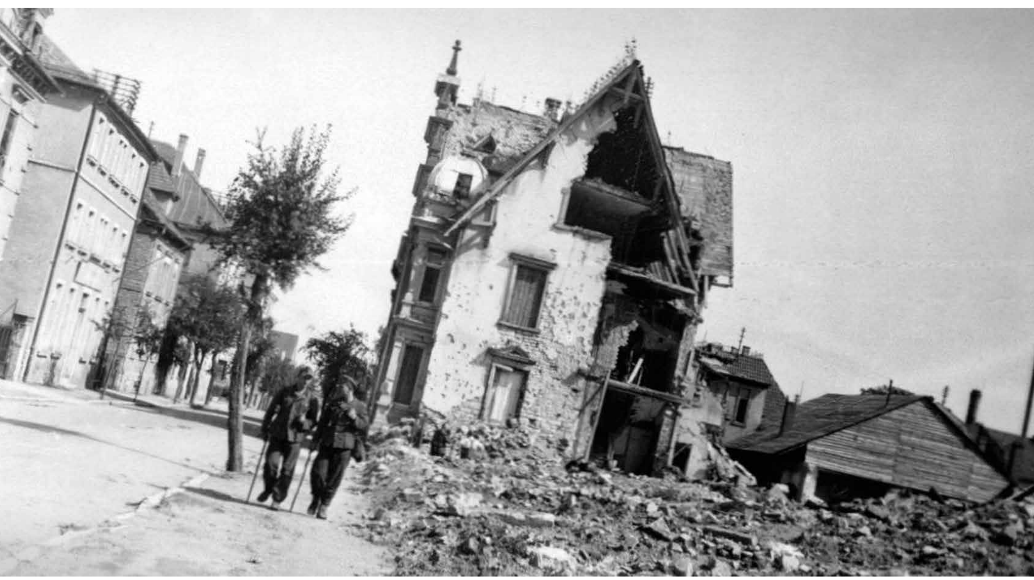
Trümmer an den Straßen - wie hier im Bereich Bismarck- und Wörthstraße
