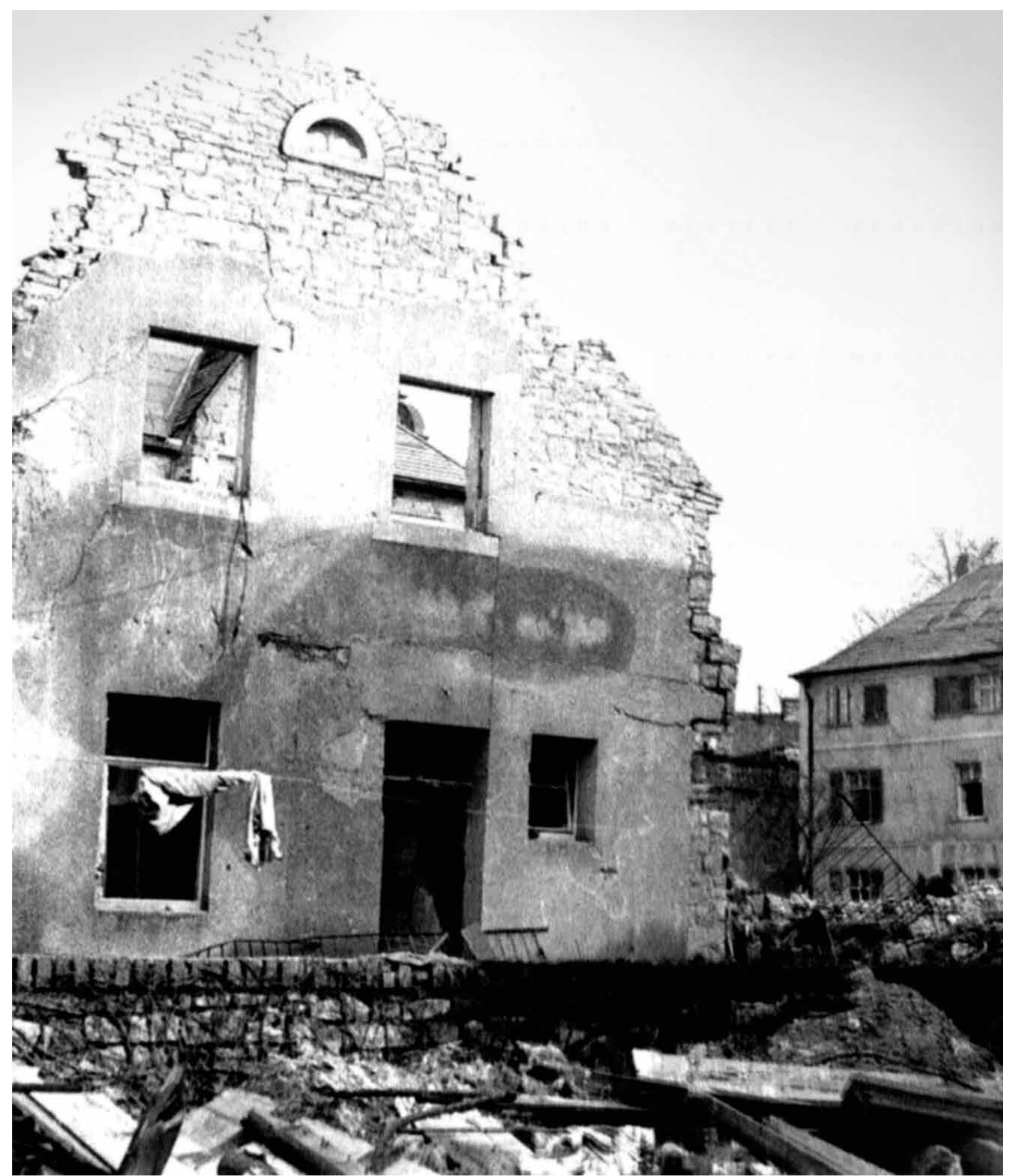
Zerstörtes Haus in der Bismarckstraße
