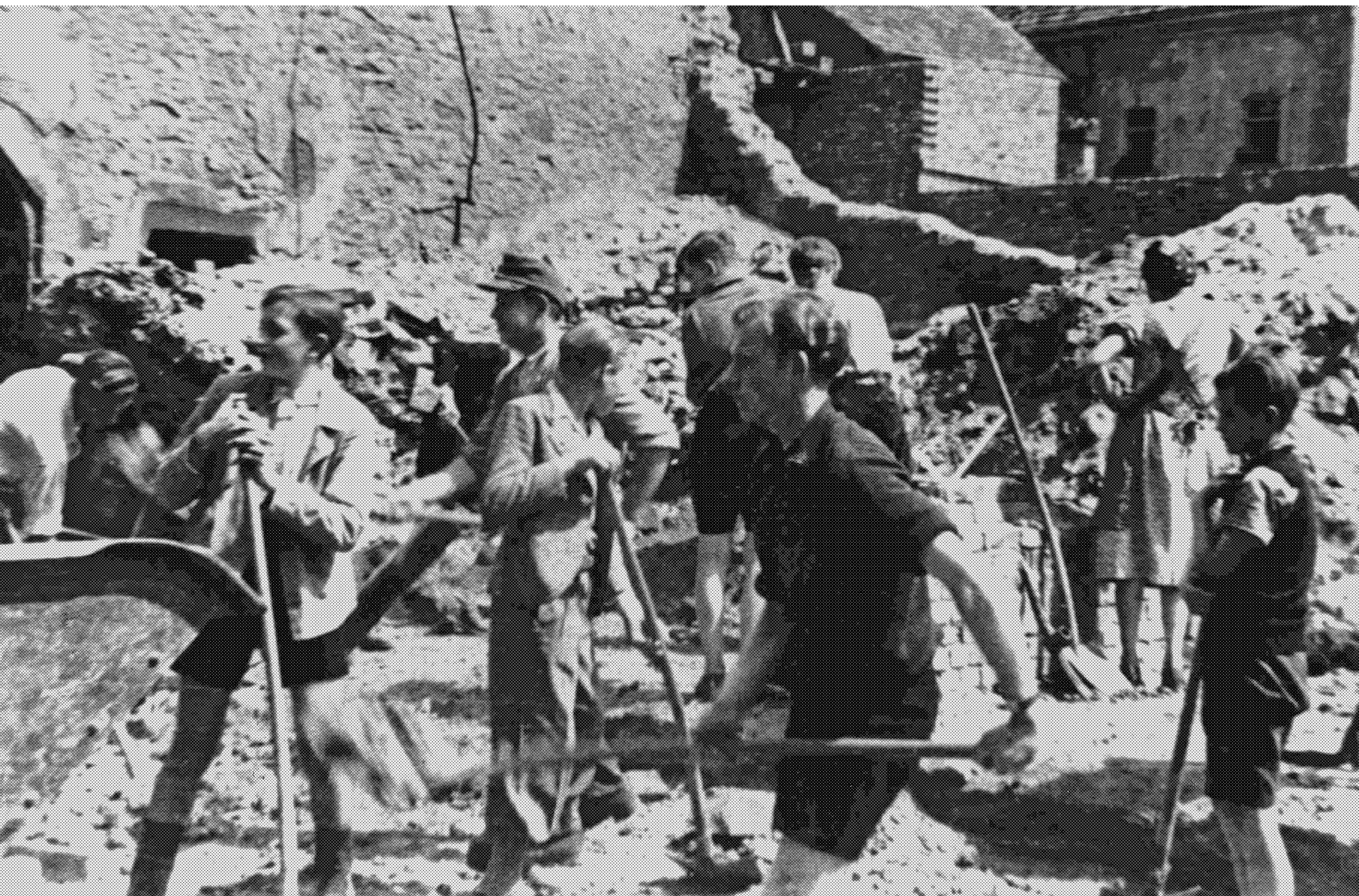
Aufräumarbeiten in der Herrstraße
