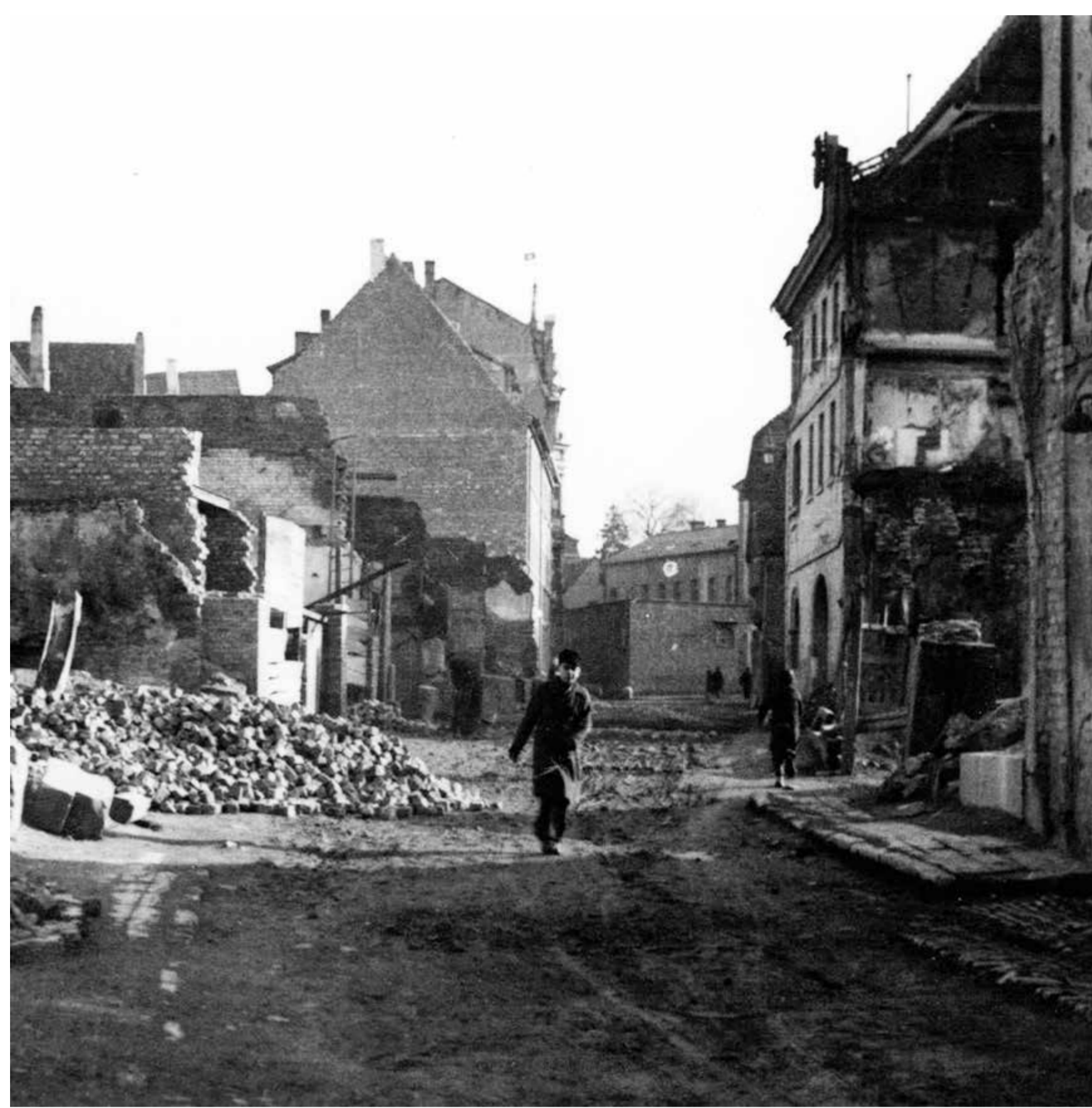
Nach dem ersten Aufräumen in der Herrstraße
