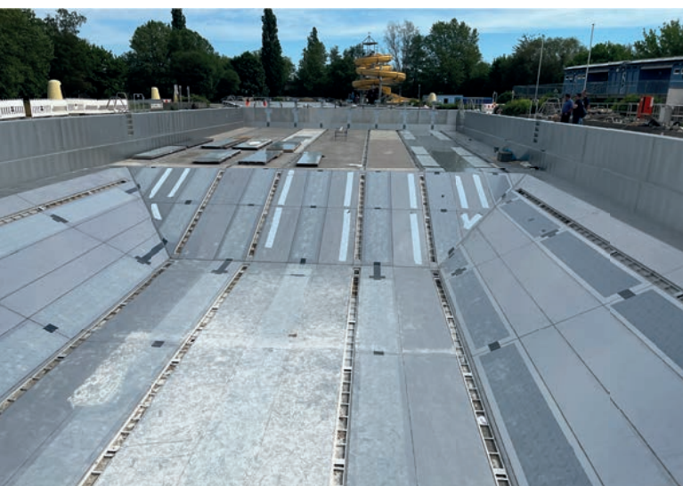
Das Schwimmerbecken wurde mit neuen Edelstahlplatten ausgekleidet.
