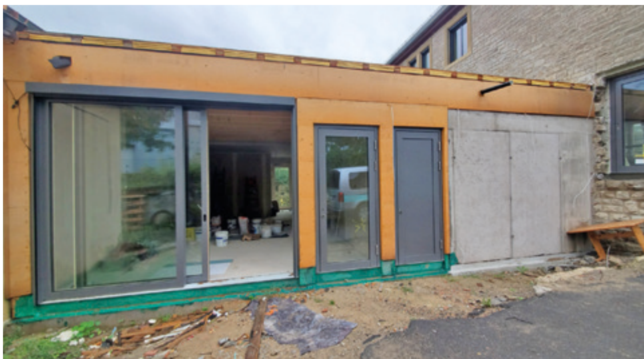
Ein neuer Verbindungsbau in Holzbauweise verbindet den alten Kindergarten mit der frisch renovierten Krippe.
