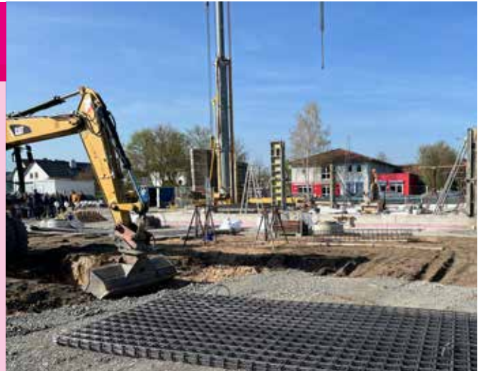
Der Erweiterungsbau für St. Michael ist schon fortgeschritten. Ab September 2026 sollen hier Krippen- und Kindergartenkinder eine neue Heimat finden.
