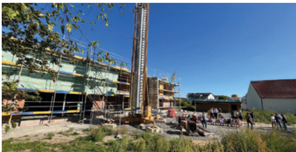
Der Neubau für den Kindergarten St. Michael in Etwashausen schreitet voran.
